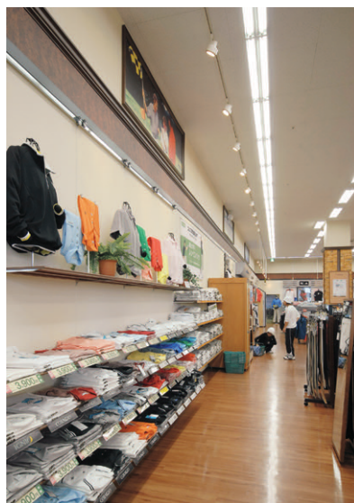
壁面ディスプレイ ライティングレール用スポットライトで効果的な演出。壁面側のラインだけが蛍光灯器具に鏡面仕上げの反射板を採用
