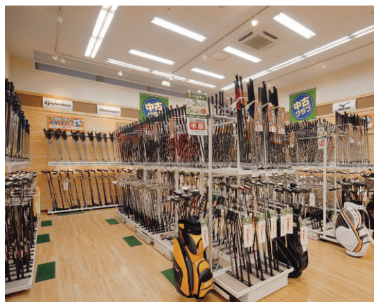
ゴルフクラブ売場 HF32W2灯用下面開放器具で売場展示に合わせた器具レイアウトを採用。見せ方を重視した効率的な明るさを確保している
