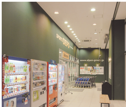
風除室 外側はFHT42W3灯用蛍光灯ダウンライト、入口側はHID250W1灯用ダウンライトを連続配置して集客を誘う
